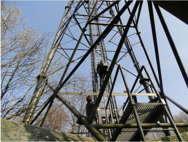
Mast aan de Kwaaklaan (Oegstgeest)
