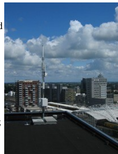
Webcam voor nieuwbouw ROC Leiden geplaatst bij LUMC, zichtbaar op het internet via Wireless Leiden.
